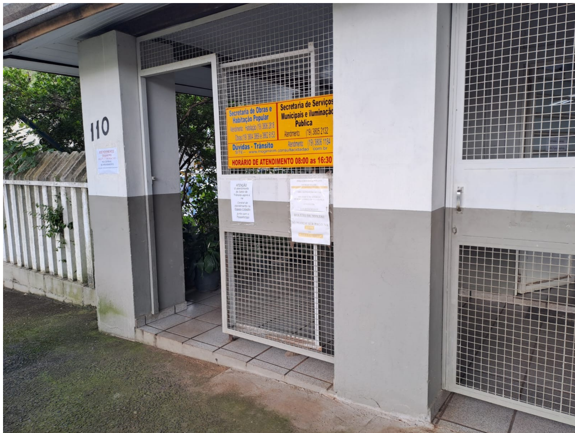
Entrada sem acessibilidade
