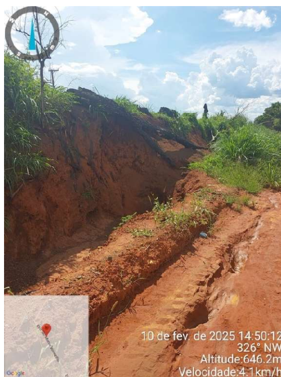
Figura 4: MMR 050 – setor 1 - sulcos de erosão nas laterais da plataforma
