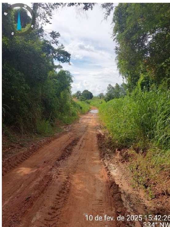
Figura 18: MMR 050 – setor 2 – formação de borrachudo que causa atoleiros e impede o tráfego de veículos
