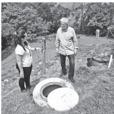
Técnicos fizeram visita a Socorro, onde trabalho resultou até agora na instalação de mais de 300 biodigestores
