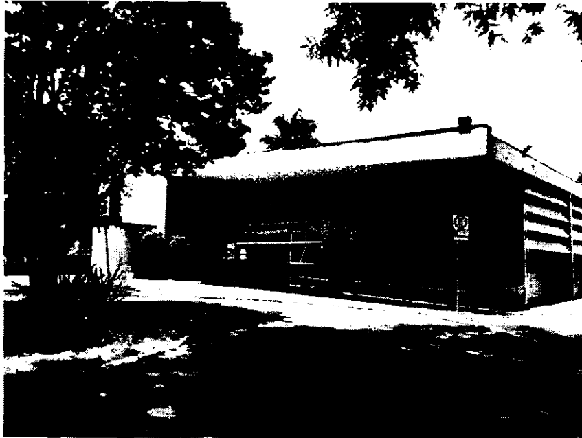
Foto 3 – Centro Cultural - Lateral para o prolongamento da Rua Coronel Leitão
