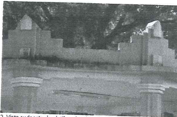
2. Vista sudoeste da platibanda e beiral.
