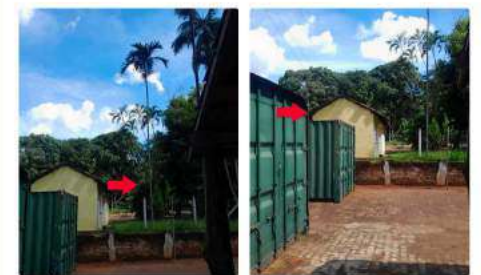
CONDIÇÃO DO LOCAL Exposição a ventos fortes com espaço restrito. PROBABILIDADE DE IMPACTO Mobilário urbano próximo.
