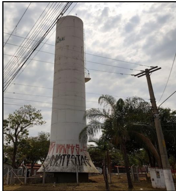
Figura 76 - Reservatório do Chico Mendes
