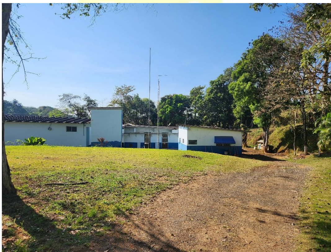
Figura 19 - Vista externa da EEAB
