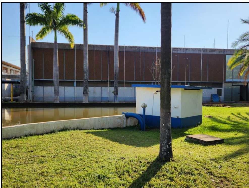
Figura 27 - Estação de Tratamento de Água
