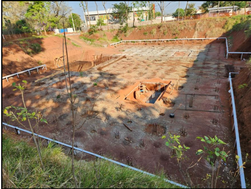
Figura 48 - Reservatório de 5.000 m 3 em construção
