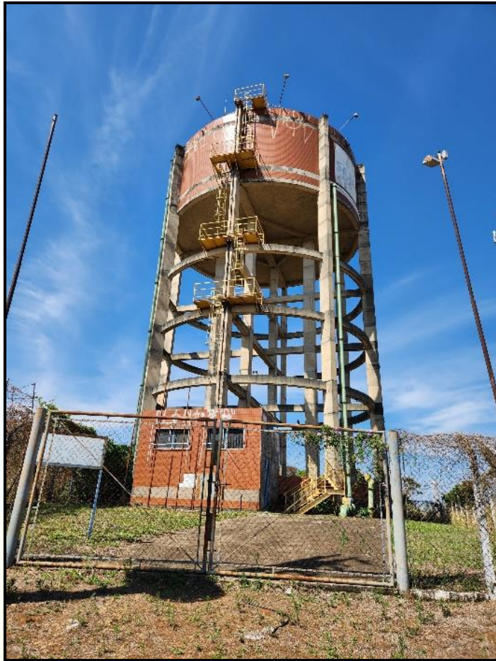
Figura 66 - Reservatório Jardim Paulista
