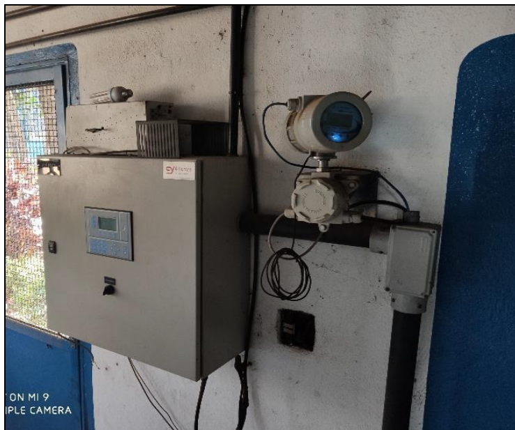
Figura 53 - Painel de telemetria da estação elevatória da Sede
