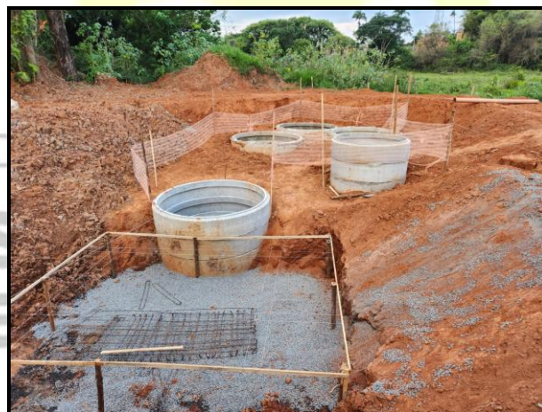
Figura 110 - Canteiro de obras da construção da EEE de Martim Francisco
