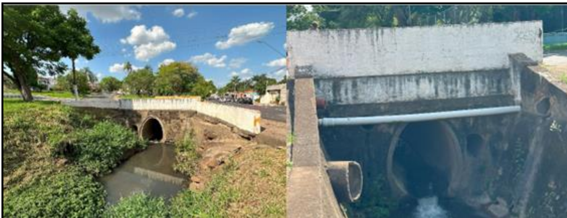
Figura 132 - Travessia (TR03) da Rua Dona Sinhazinha sobre o Córrego Lavapés
