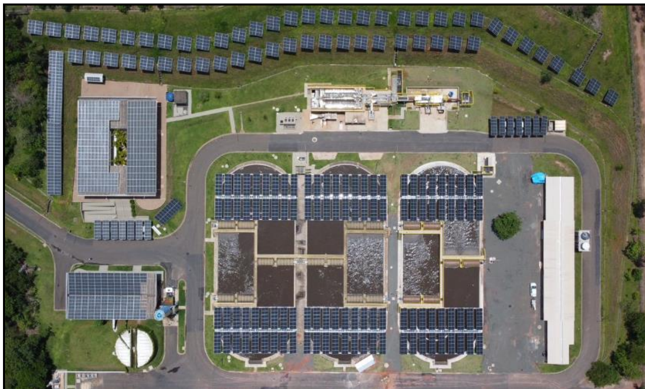
Figura 106 - Usina fotovoltaica da ETE de Mogi Mirim
