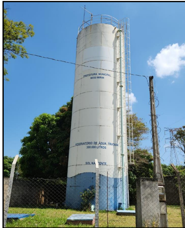
Figura 80 - Reservatório Chácaras Sol Nascente
