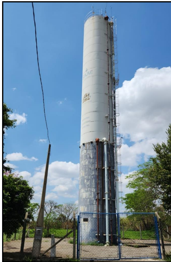
Figura 82 - Reservatório Martim Francisco
