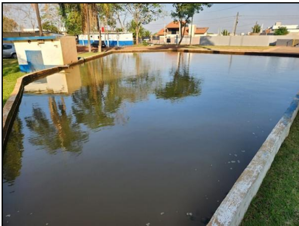
Figura 37 - Reuso das águas de lavagem dos filtros
