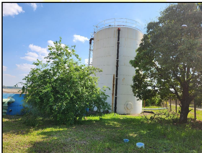
Figura 79 - Reservatório apoiado do Parque das Empresas
