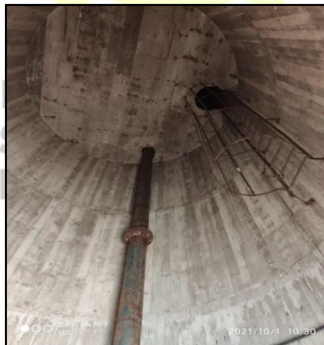
Figura 77 - Parte interna do reservatório do Chico Mendes
