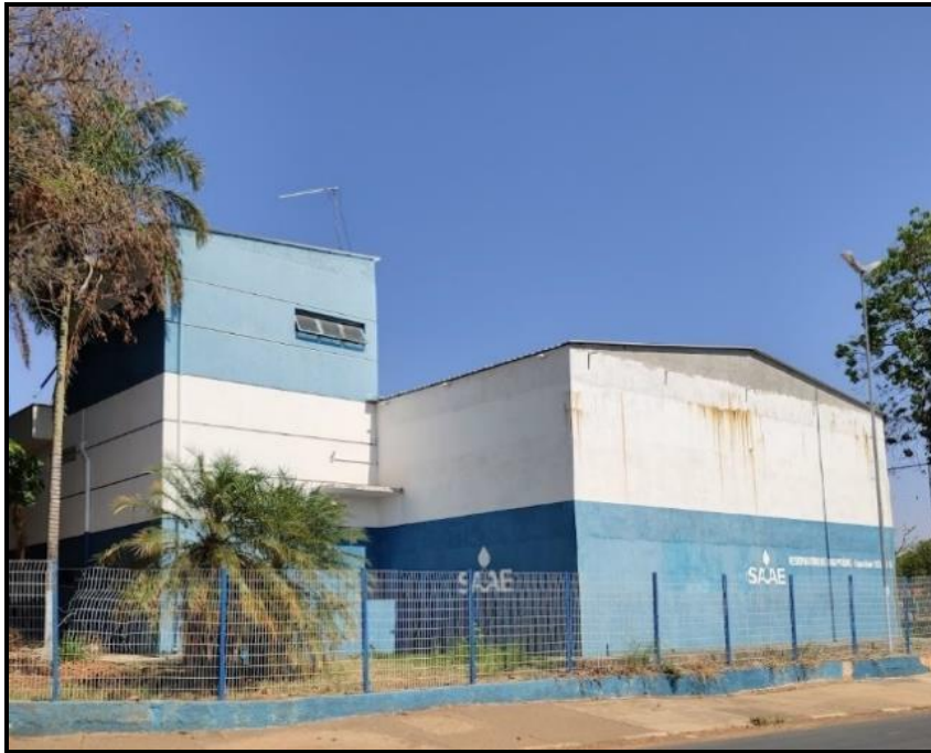
Figura 62 - Reservatório Catarino Marangoni
