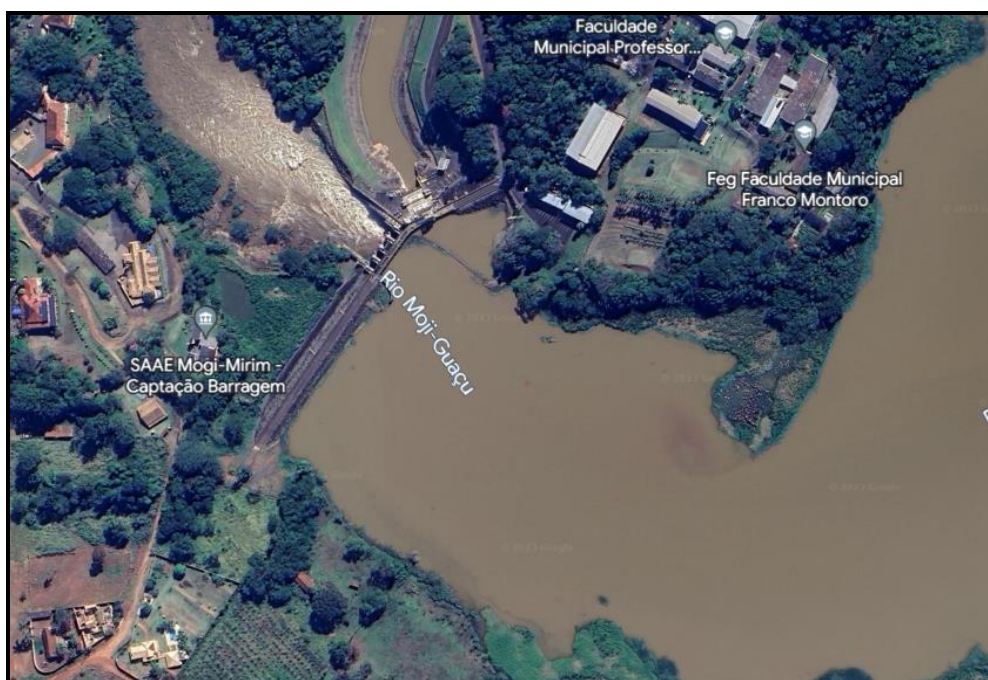
Figura 18 - Localização da Captação de água bruta
