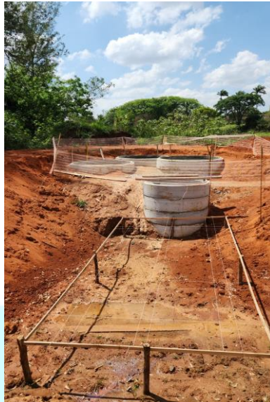
Figura 109 - Canteiro de obras da construção da EEE de Martim Francisco
