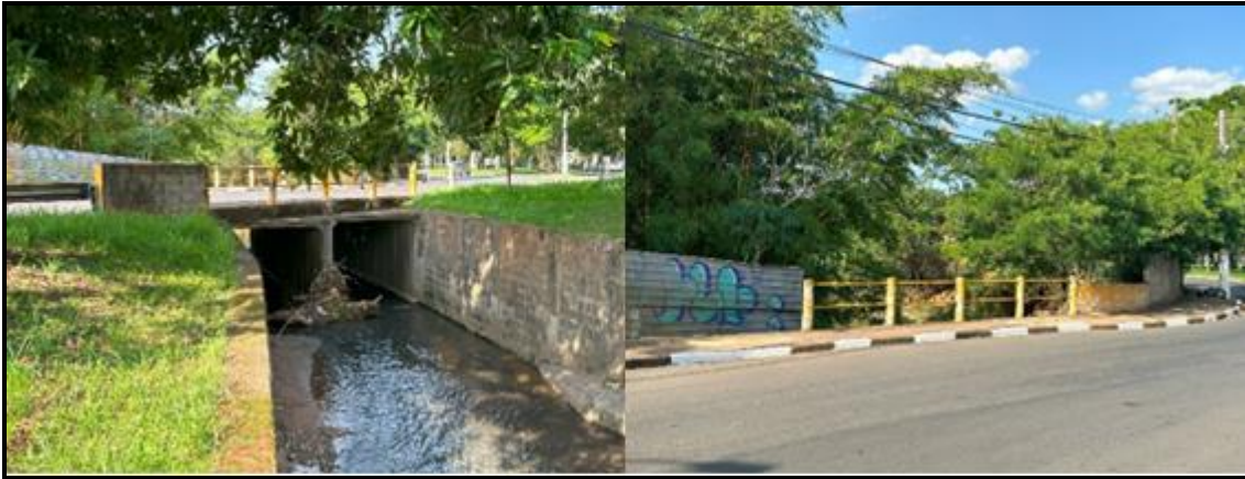
Figura 130 - Travessia (TR01) da Avenida Brasil sobre o Córrego Santo Antônio
