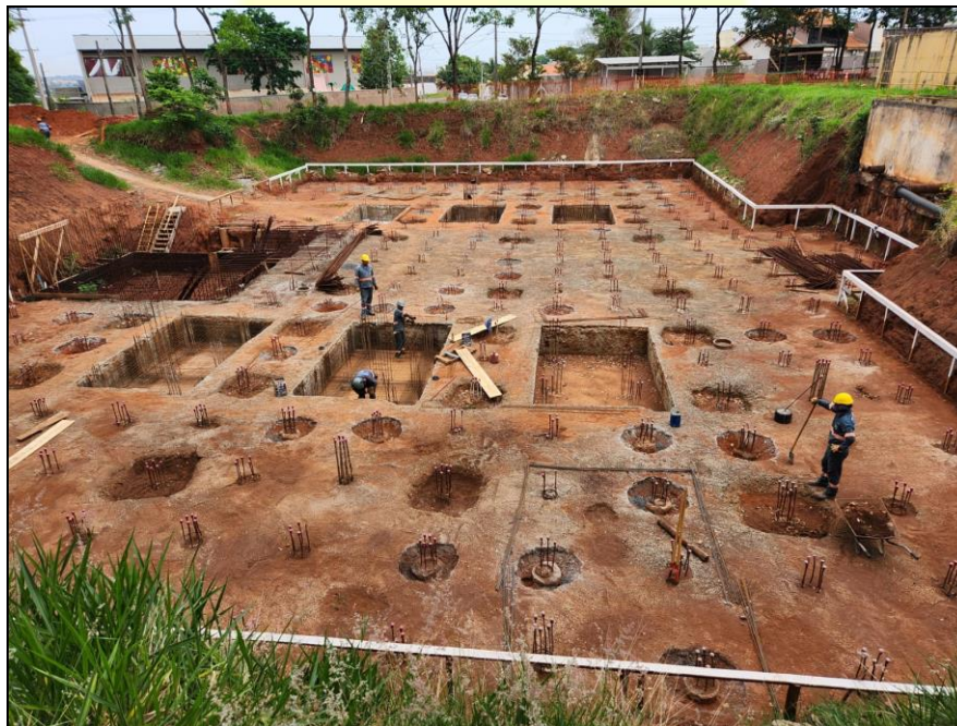
Figura 31 - Reservatório em construção – 5.000 m 3
