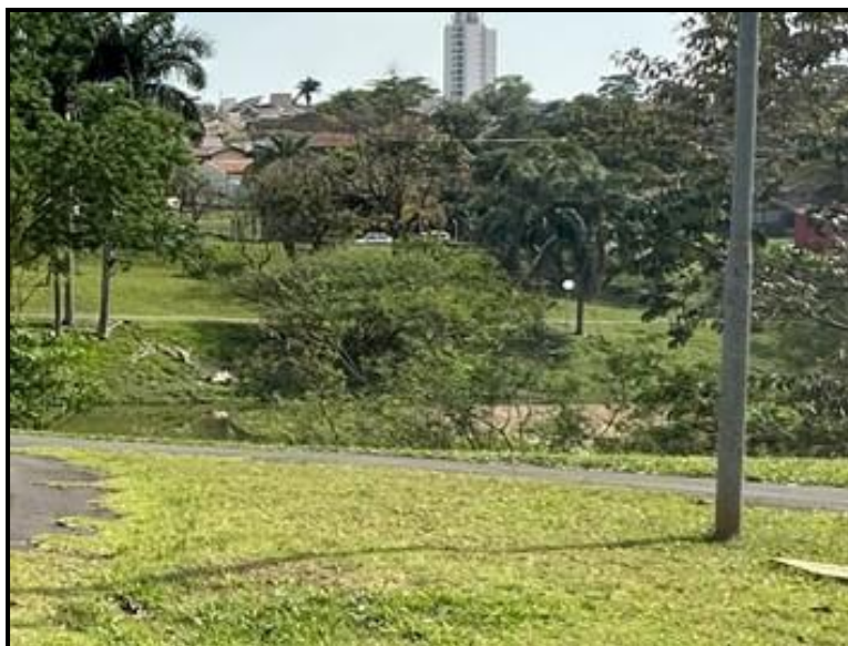
Figura 135 - Assoreamento no barramento do Córrego Lavapés
