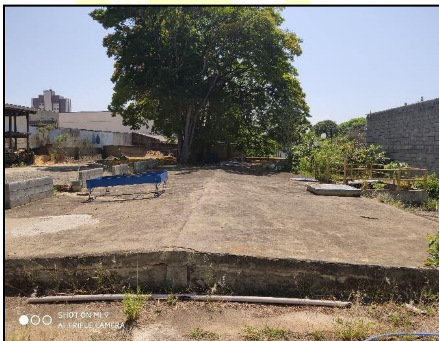
Figura 51 - Reservatório retangular da Sede (estaleiro)
