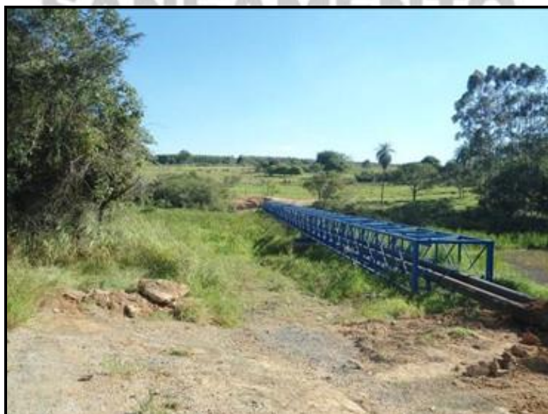
Figura 25 - Travessia das adutoras
