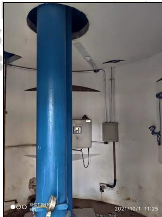
Figura 75 - Parte interna do reservatório do Cálice
