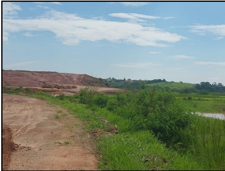
Figura 133 - Assoreamento no Rio Mogi Mirim devido a terraplanagem
