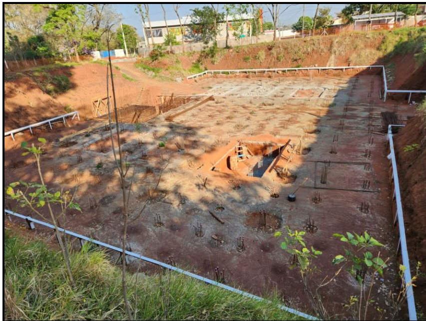
Figura 30 - Reservatório em construção – 5.000 m 3
