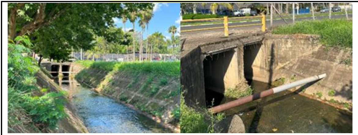
Figura 131 - Travessia (TR02) da Avenida Prof. Adib Chaib sobre o Córrego Lavapés
