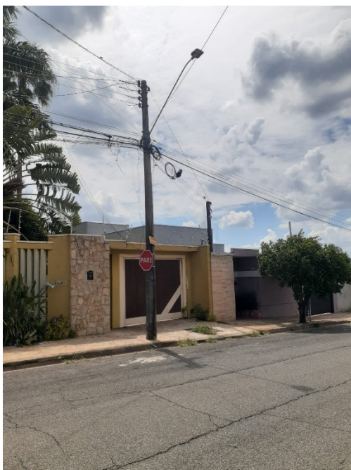
Figura 06. (Fios estourados e amarrados no poste de iluminação pública Rua Irsom Alves da Silva).
