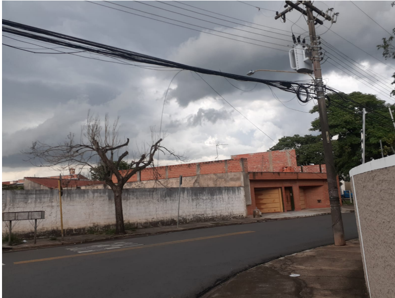
Figura 04. . ( Fios estourados amarrados no poste de iluminação, Rua Pedro Teruel).
