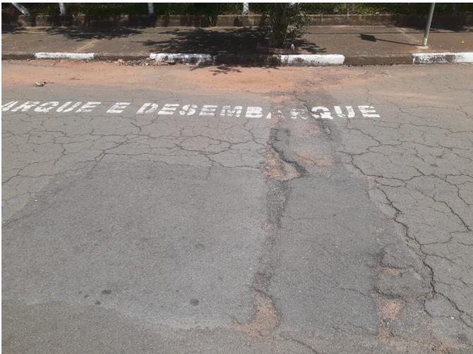
Figura 04. Sinalização horizontal em mau estado de conservação apagada devido aos intemperes e desgastes do tempo, precisando ser refeita.
