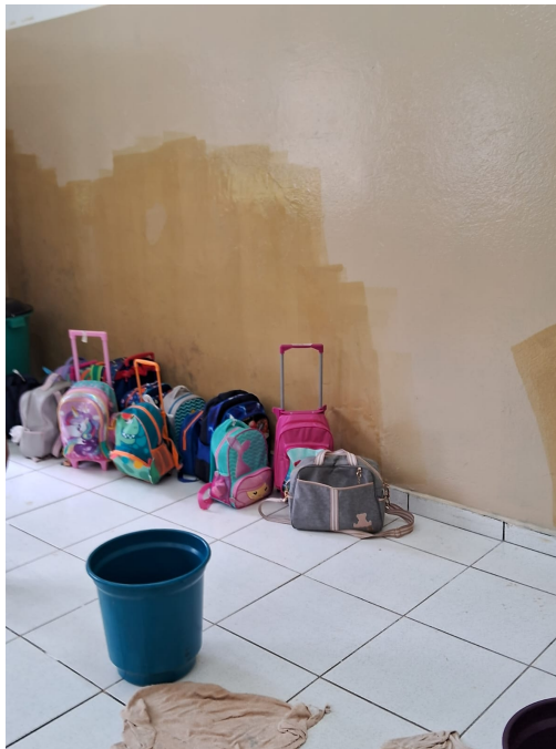
Foto 03 e 04. Goteira dentro da sala de aula; parede da sala de aula úmida.
