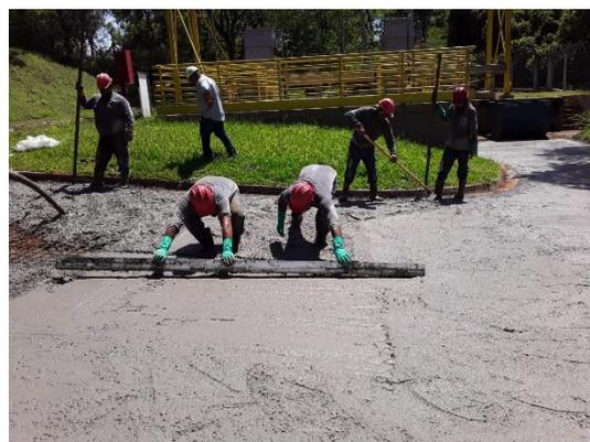
**Foto 46 e 47:** Execução de Piso de Concreto armado – acesso a Elevatória - ETE.
