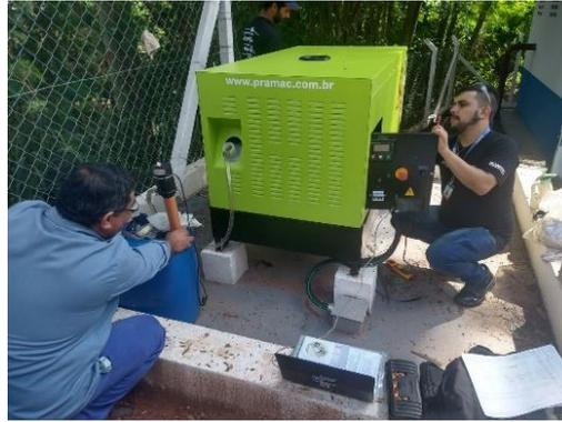
**Foto 68 e 69:** Serviço de alinhamento a laser das bombas e Startup do gerador - Estação Elevatória – CT Mogi Mirim.
