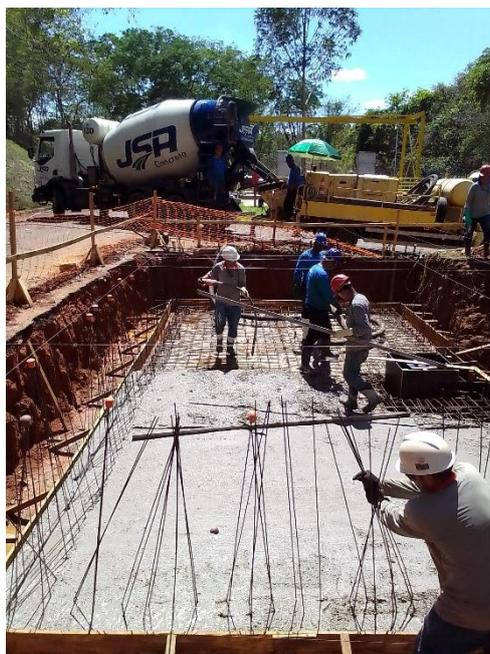
**Foto 40 e 41:** Execução de caixa de esgoto não doméstico - ETE.
