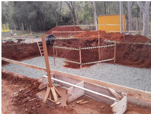
**Foto 38 e 39:** Execução de caixa de esgoto não doméstico - ETE.
