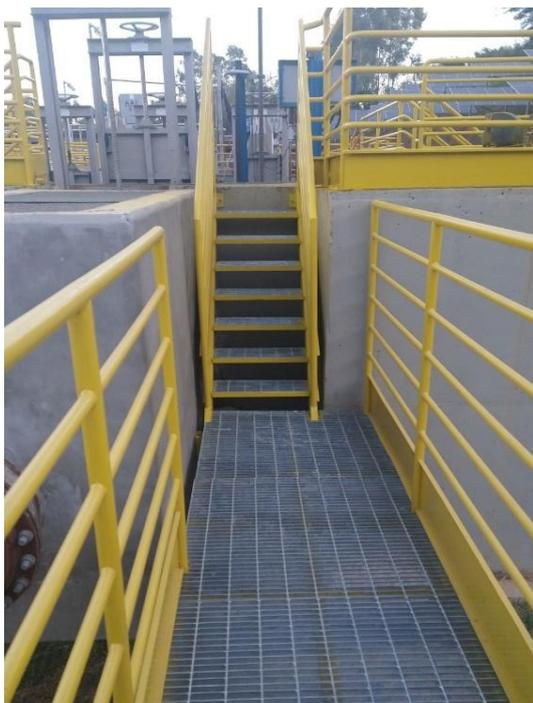
**Foto 3:** Finalização da instalação de grades e passarela metálica, Tratamento Preliminar – ETE.
