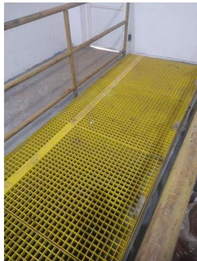
**Foto 64 e 65:** Instalação de grades pultrudadas e guarda corpo - Estação Elevatória – CT Mogi Mirim.
