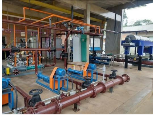
**Foto 30 e 31:** Instalação hidromecânica de novo conjunto de centrífuga – Prédio de Desidratação – ETE.
