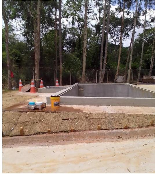
**Foto 42 e 43:** Execução de caixa de esgoto não doméstico - ETE.
