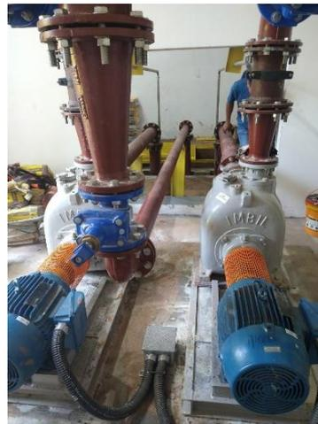
**Foto 70 e 71:** Execução de grauteamento das bases das bombas, finalização de instalação das bombas - Estação Elevatória – CT Mogi Mirim.
