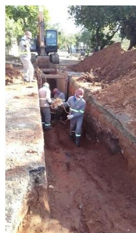
**Foto 91 / 92 / 93:** Execução do PV 4 e assentamento de tubulação e compactação de solo no trecho Rede Imaculada – CT Santo Antônio.
