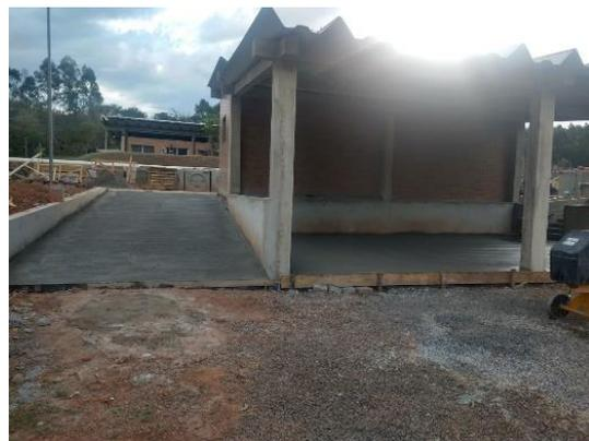
**Foto 22 e 23:** Execução de piso da Oficina e concretagem da rampa de acesso – ETE.
