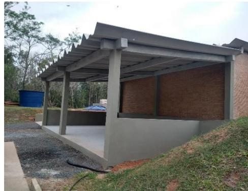
**Foto 26 e 27:** Finalização da Oficina, pintura e acabamento em concreto aparente das estruturas e Rampa de acesso – ETE.
