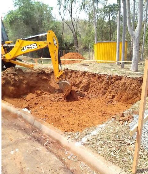
**Foto 36 e 37:** Execução de caixa de esgoto não doméstico - ETE.
