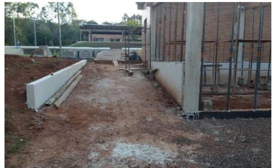
**Foto 16 e 17:** Execução de estruturas de concreto (vigas e pilares) da Oficina e rampa de acesso - ETE.
