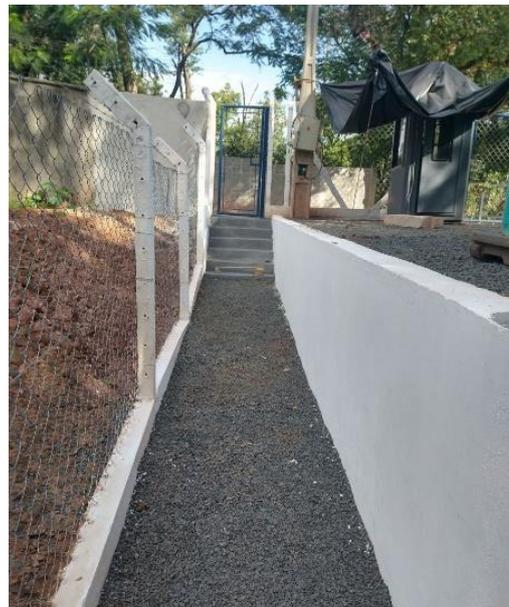
**Foto 72 e 73:** Finalização de escada de acesso, acabamento em pintura e espalhamento de brita - Estação Elevatória – CT Mogi Mirim.
