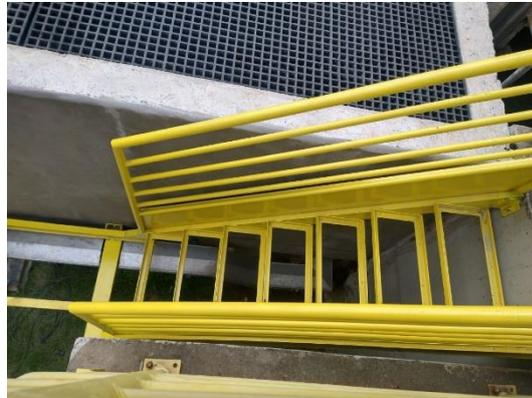
**Foto 1 e 2:** Instalação de passarela metálica para interligação das duas unidades de Tratamento Preliminar – ETE.
