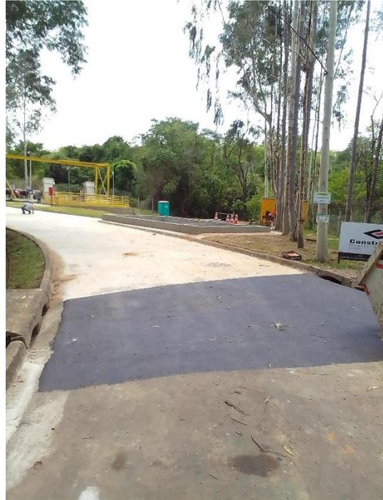
**Foto 48 e 49:** Execução de Piso de Concreto armado – acesso a Elevatória - ETE.
