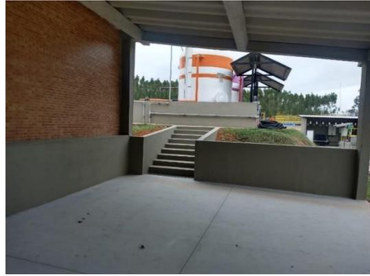
**Foto 24 e 25:** Finalização da Oficina, pintura e acabamento em concreto aparente das estruturas e Rampa de acesso – ETE.
