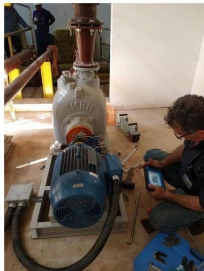
**Foto 66 e 67:** Serviço de alinhamento a laser das bombas - Estação Elevatória – CT Mogi Mirim.
