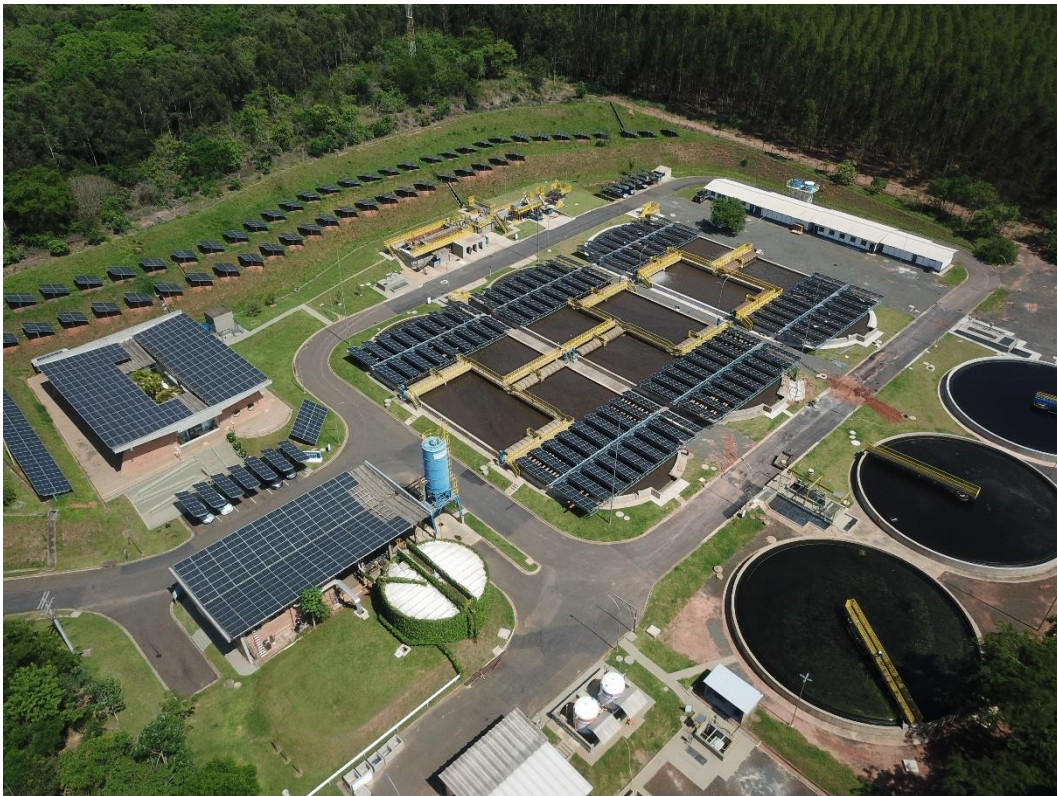
Foto 17: Vista geral com ampliação da Usina Fotovoltaica- ETE finalizada.
