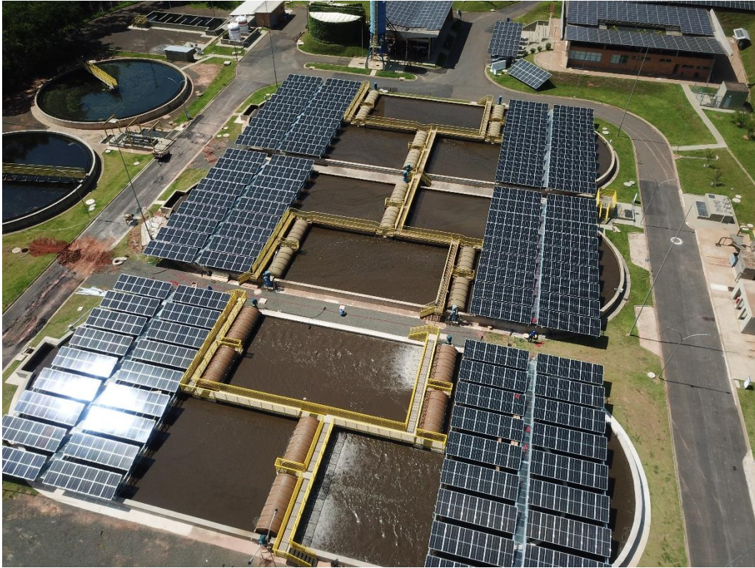
Foto 16: Vista geral com ampliação da Usina Fotovoltaica- ETE finalizada.
