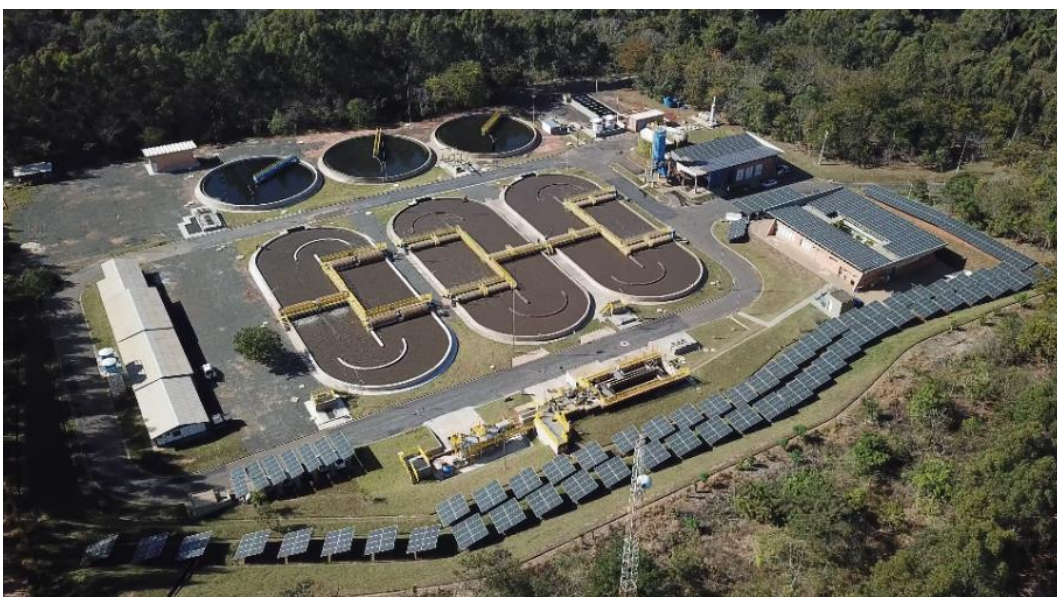
Foto 15: Vista geral da 3ª Etapa de ampliação - ETE finalizada.
