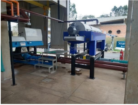
Fotos 6 e 7: Conjunto de centrífuga e bombas – Prédio de Desidratação – ETE.
