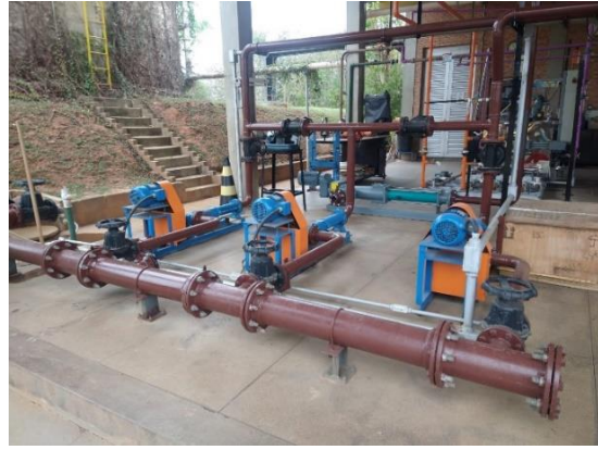
Fotos 6 e 7: Conjunto de centrífuga e bombas – Prédio de Desidratação – ETE.
