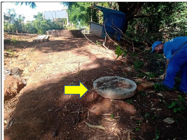
PV nivelado ao nível do solo
