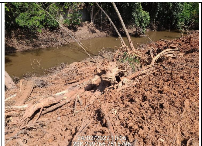
PV 34 - árvores caídas
