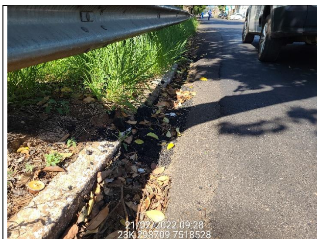
Deposição de cimento betuminoso
