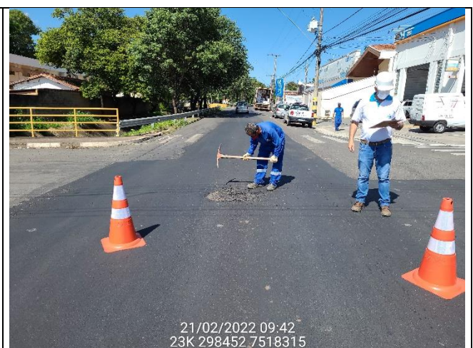
PV 13 desnivelado
