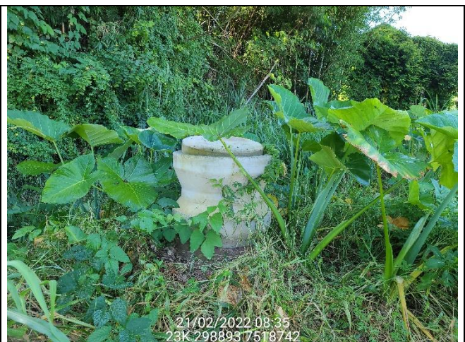
Não há o encaixe perfeito do tampão junto a bolsa
