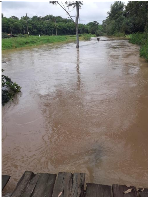
Inundação ocorrida nesta região (foto fornecida pelo proprietário do imóvel)
