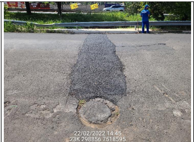
Pavimento ainda em binder
