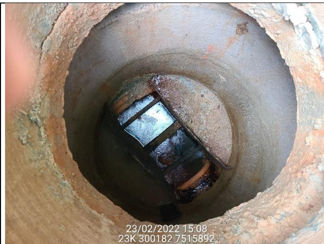
PV 45 com formas da canaleta
