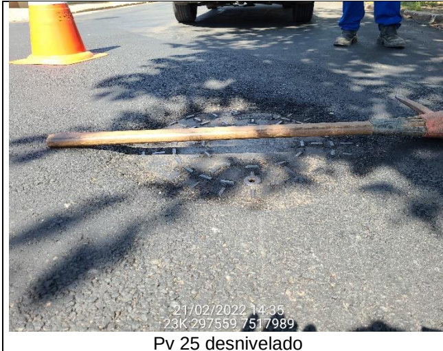
Pv 25 desnivelado
