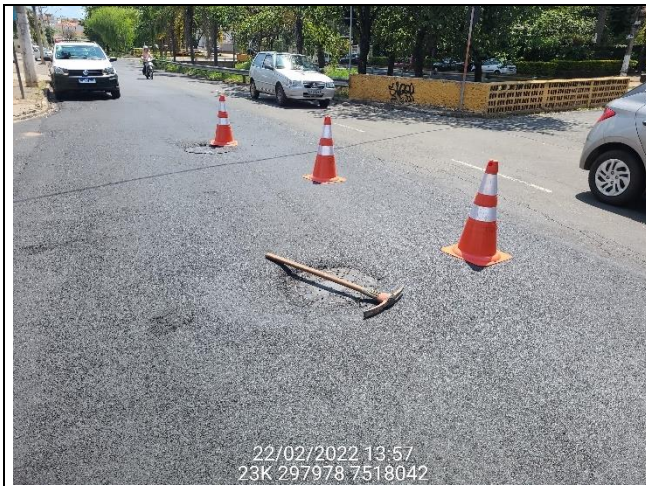
PV 42 desnivelado
