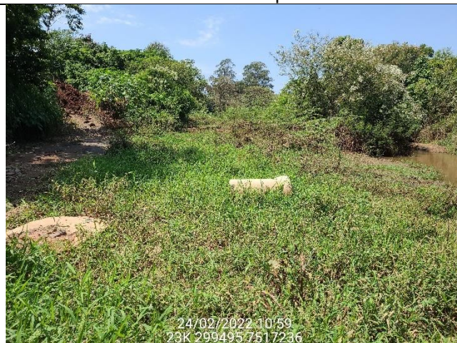
PV 26 – restos de material de construção
