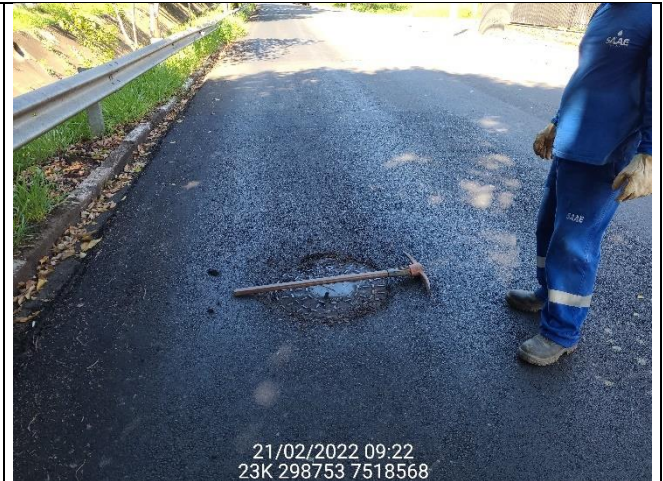
PV 08 - desnivelado
