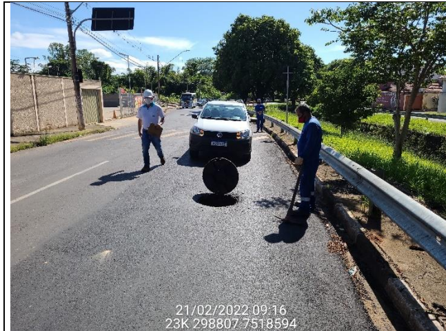
PV 07 - desnivelado
