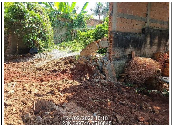
PV 34 – muro não restituído
