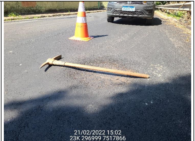
PV 35 desnivelado
