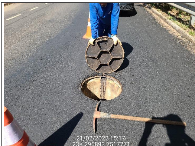
PV 37 desnivelado
