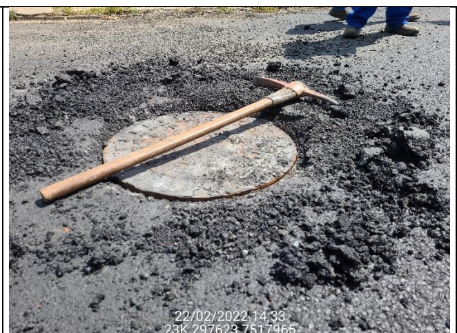
PV 47 desnivelado
