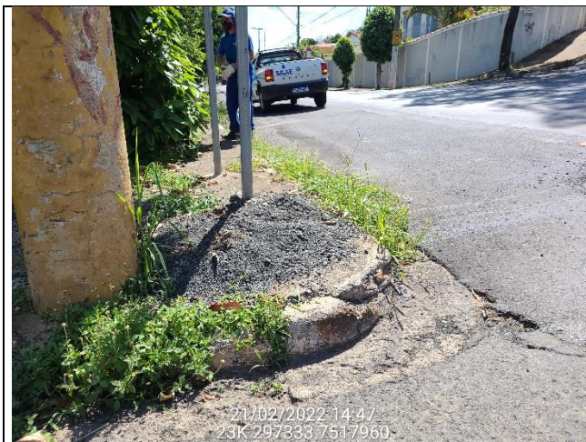
Disposição de material agregado
