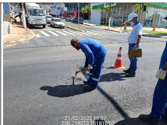
PV 18 desnivelado
