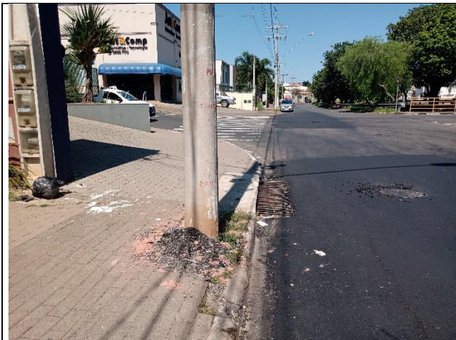
Disposição inadequada de agregado
