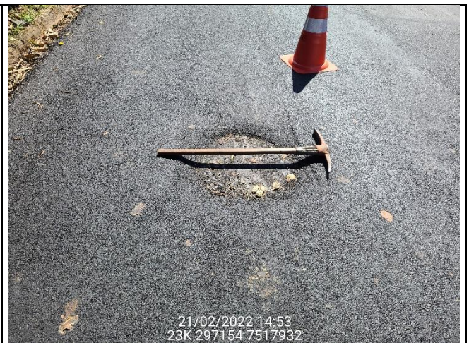
PV 30 desnivelado
