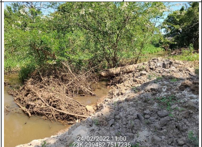
PV 26 - árvore sobre o Rio
