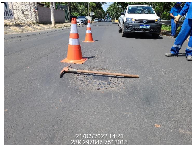
Pv desnivelado
