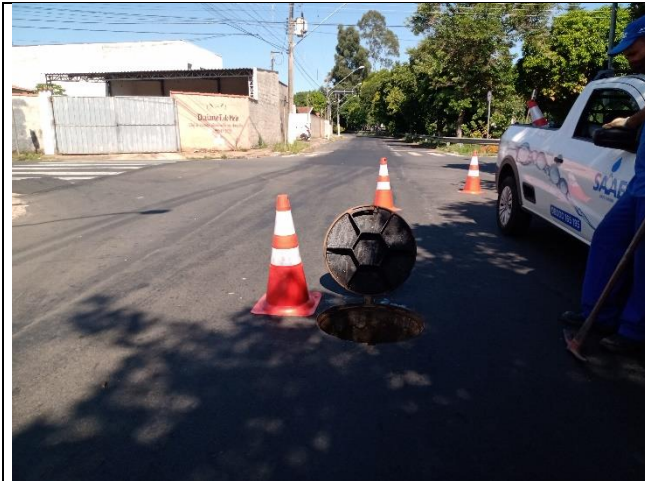
PV 48 com problema de ajuste (ruído)
