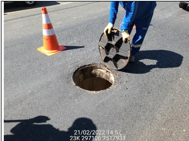
PV 34 desnivelado
