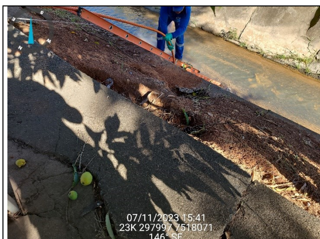
Desobstrução da rede por hidrojateamento
