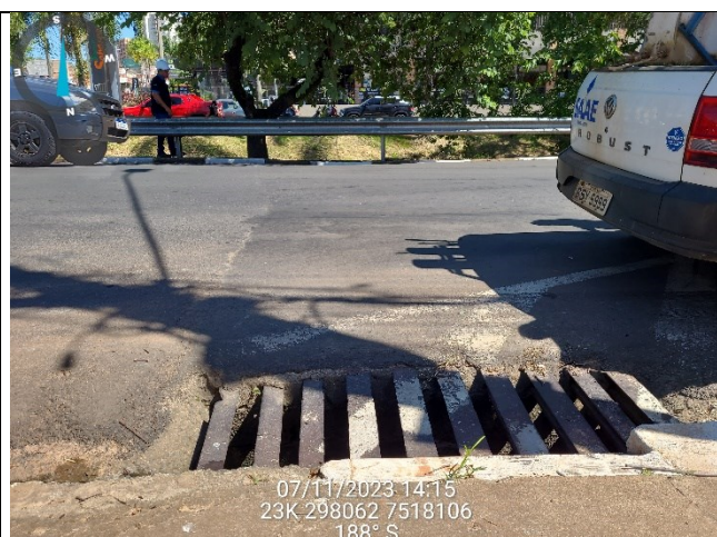
Detalhe do início da GAP entupida
