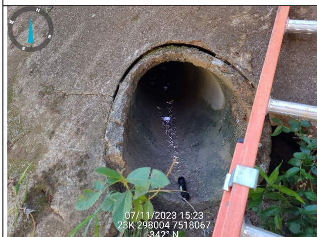
Deslocamento da tubulação no ponto de desague da GAP
