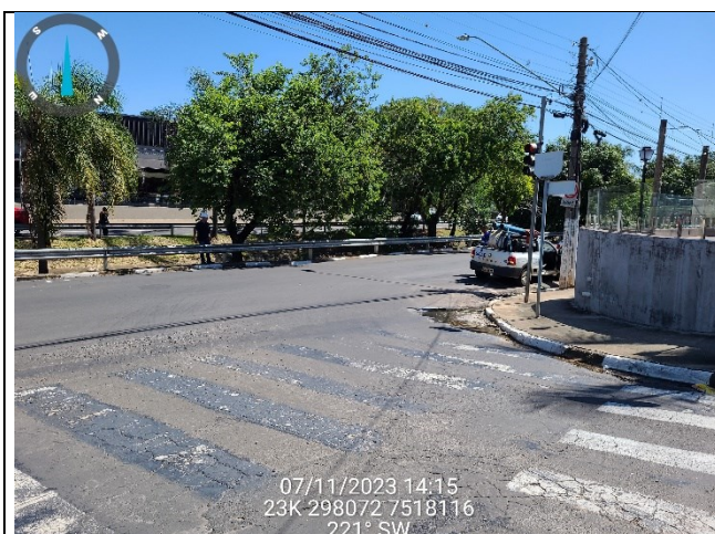
Região da GAP obstruída (proximidades do PV 18)
