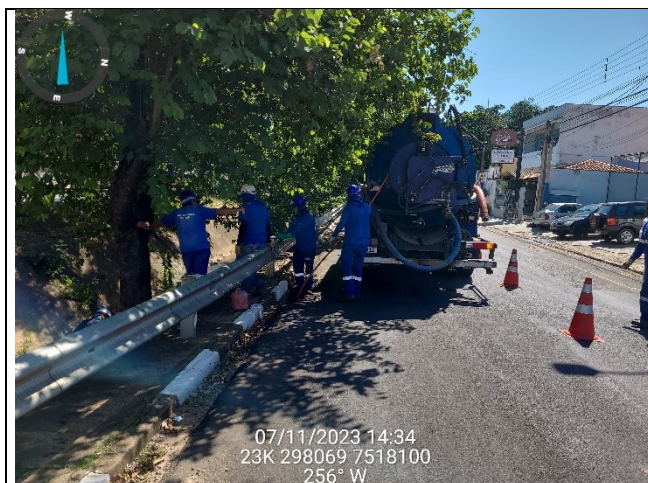
Desobstrução da rede por hidrojetamento
