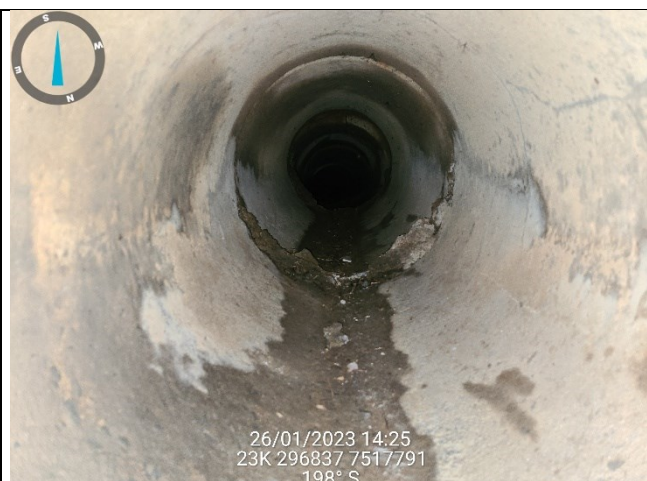
Detalhe do interior da Galeria de Águas Pluviais, não sendo identificado visualmente o ponto de obstrução
