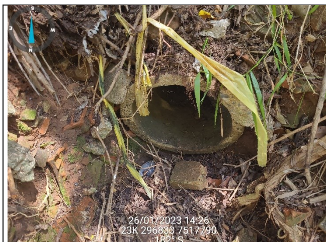
Saída da GAP de 400 mm, ponto de visualização do interior da rede
