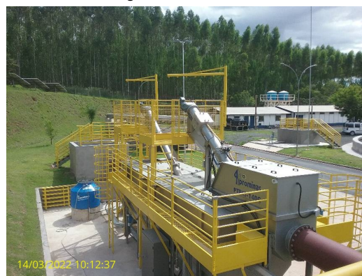
Foto 4 - Módulos de gradeamento - 3ª Etapa
