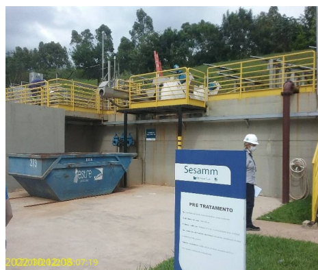
Foto 27 - Módulo de gradeamento 1ª e 2ª Etapa
