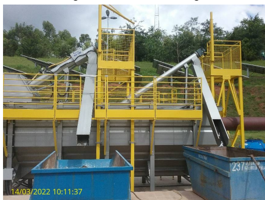
Foto 3 - Módulos de gradeamento - 3ª Etapa
