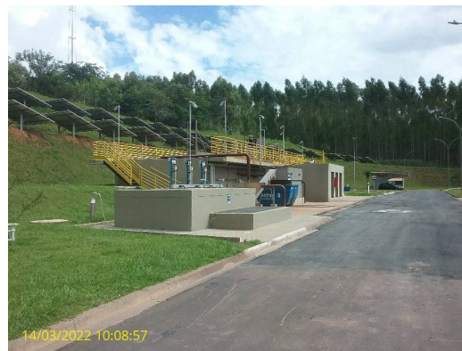
Foto 2 - vista geral do Tratamento Preliminar
