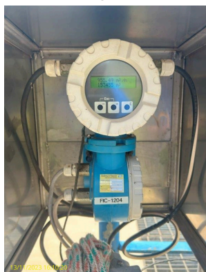
Foto 29 - Medição de vazão (saida)
