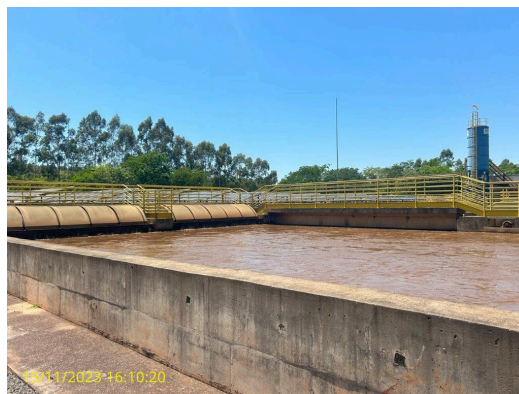
Foto 20 - Vista dos reatores de aeração
