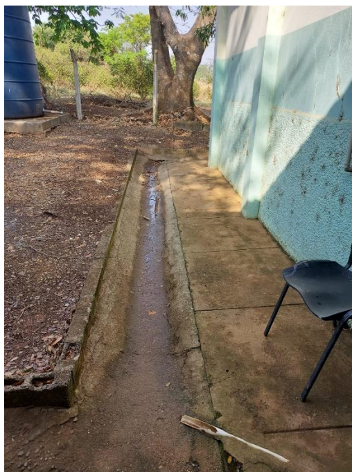
Figura 4-123. Canaleta que deságua as águas do tanque
