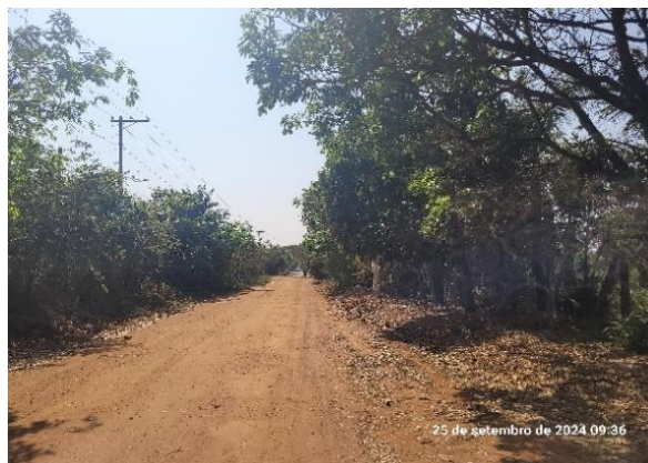
Figura 4-27. Rua Antonio Soares de Oliveira. Largura da Via 8,00 m
