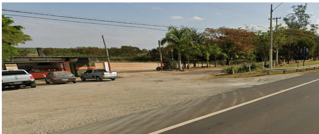
Figura 4-34. Acesso único ao Loteamento.
