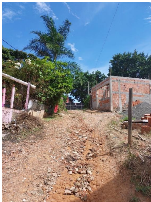
Figura 4-55. detalhe da declividade elevada no Setor 2, demonstrando situações de corte e aterro que podem gerar situações de risco às moradias.
