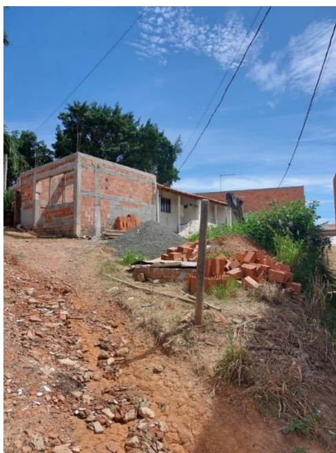
Figura 4-55. detalhe da declividade elevada no Setor 2, demonstrando situações de corte e aterro que podem gerar situações de risco às moradias.
