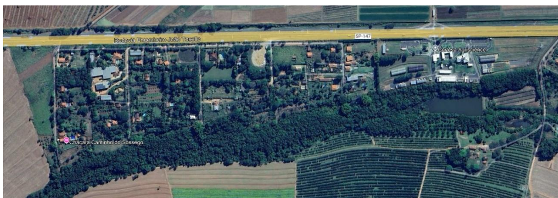
Figura 4-22. Vista geral das Chácaras Boa Vista.
