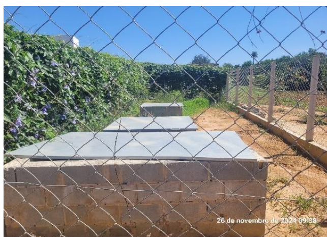
Figura 4-103. Sistema de tratamento de esgotos do restaurante Tina na Roça
