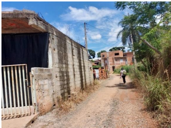
Figura 4-58. Vista das moradias do setor 3 abaixo do nível da Estrada de Servidão
